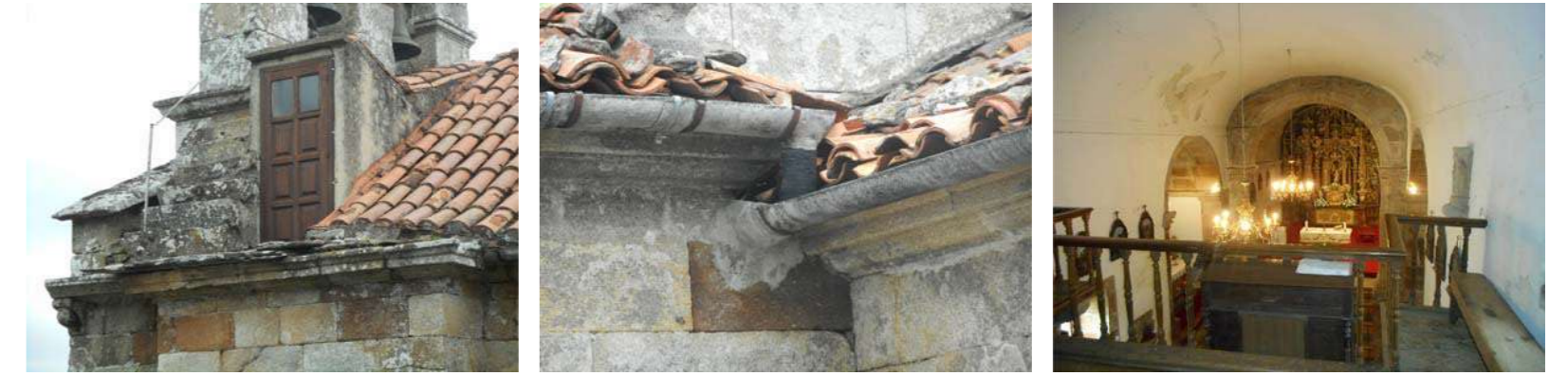
Patoloxías: Procederese á retirada da saída ao campanario e canalóns de fibrocemento, así como ao derribo e substitución da falsa bóveda da nave
