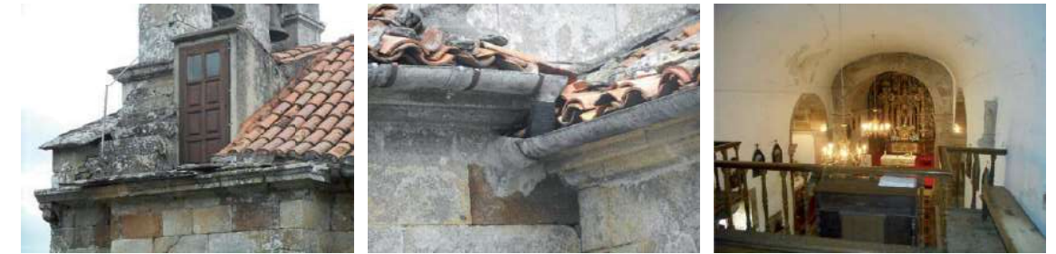
Patoloxías: Procederese á retirada da saída ao campanario e canalóns de fibrocemento, así como ao derribo e substitución da falsa bóveda da nave
